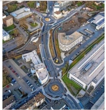
Fast ist es geschafft: Die Pferdebachstraße mit den neuen Kreisverkehren nach ihrem Umbau.
